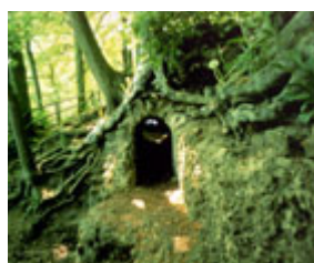
Römische Wasserleitung Eifel – Köln; Anschluss bei Kall Foto: MBV/A. Thünker
