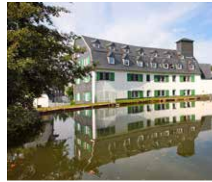
Wollspeicher der ehem. Textilfabrik Vorwerk & Co. in Wipperfürth-Niedergaul, KLB 387
