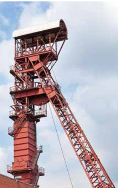
Fördergerüst von Schacht III der Zeche Sophia Jacoba in Hückelhoven, KLB 029
