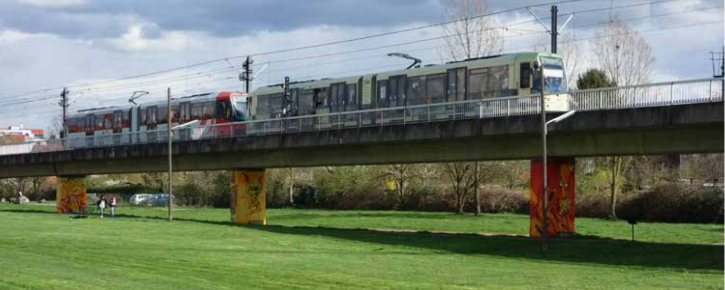
Hochbahntrasse der Kölner Stadtbahn in Mauenheim, KLB 338
