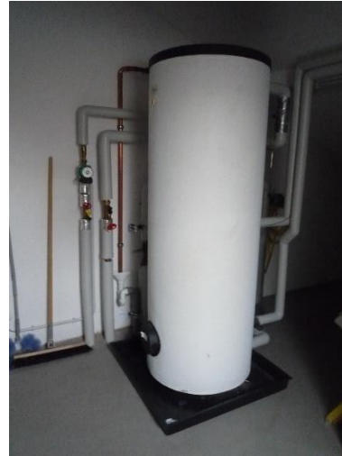
Warmwasserspeicher
