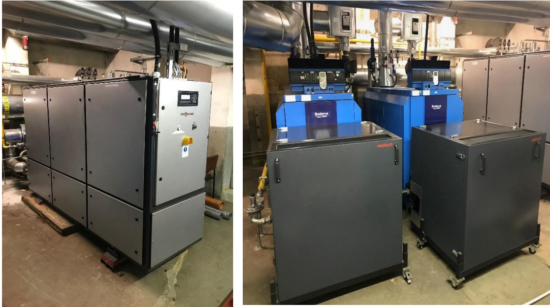
BHKW und Heizkessel Haus E
